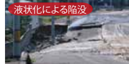
液状化による陥没
