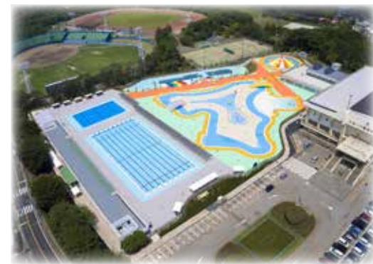
▲ 運動公園の写真 既に駐車場を有料化しているのは3施設(アンデルセン公園、三番瀬海浜公園、総合体育館)のみであり、運動公園をはじめその他の駐車場の維持管理は市税により賄われています。
